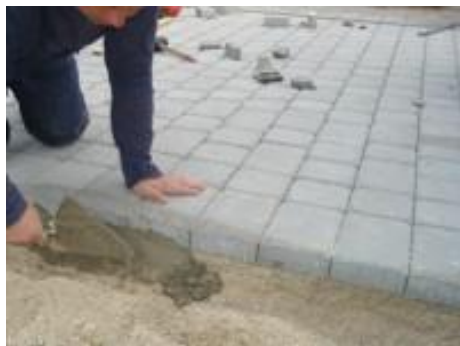
9 pav. Trinkelės rėminimas betonu
