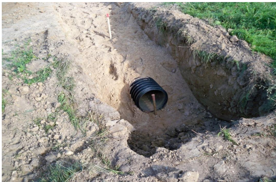
8 pav. Gofruotos plastmasinės pralaidos užpylimas gruntu
