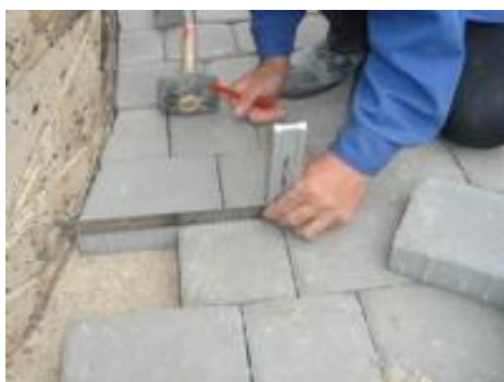
7 pav. Trinkelių žymėjimas pripjaunant
