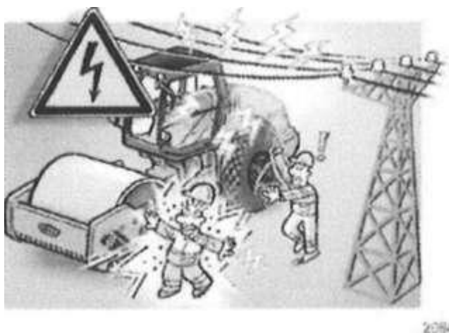
35 pav. Darbas arti elektros linijų
