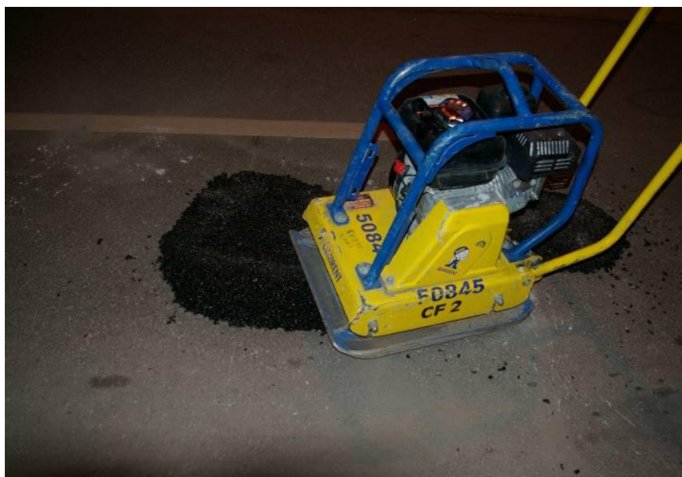
4 pav. Sutankinimas vibro plokšte
