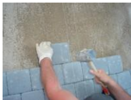
6 pav. Trinkelių klojimas
