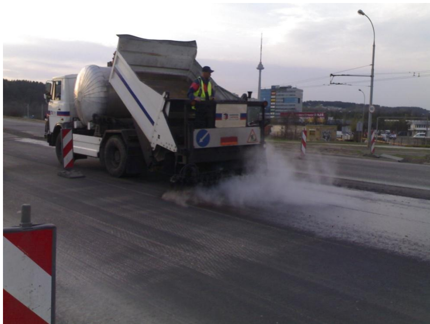
3 pav. Bituminės emulsijos paskleidimas automatizuotu rišiklio skleistuvu
