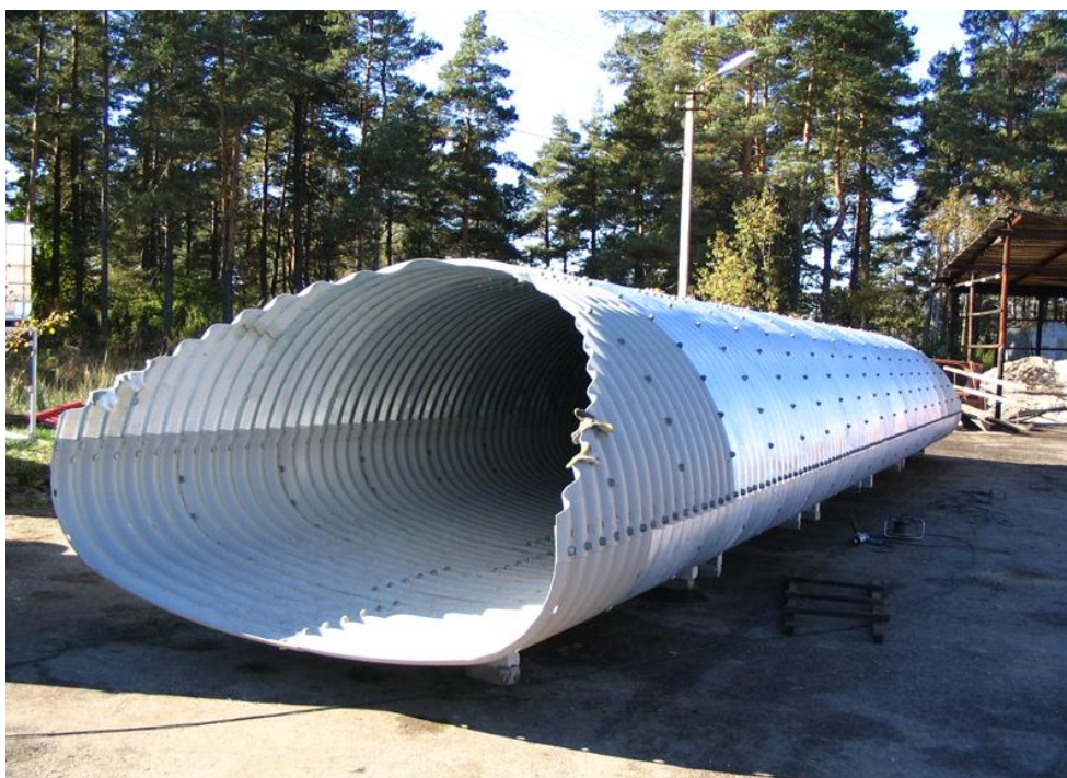
3 pav. Gofruotų metalinių vamzdžių įrengimas
