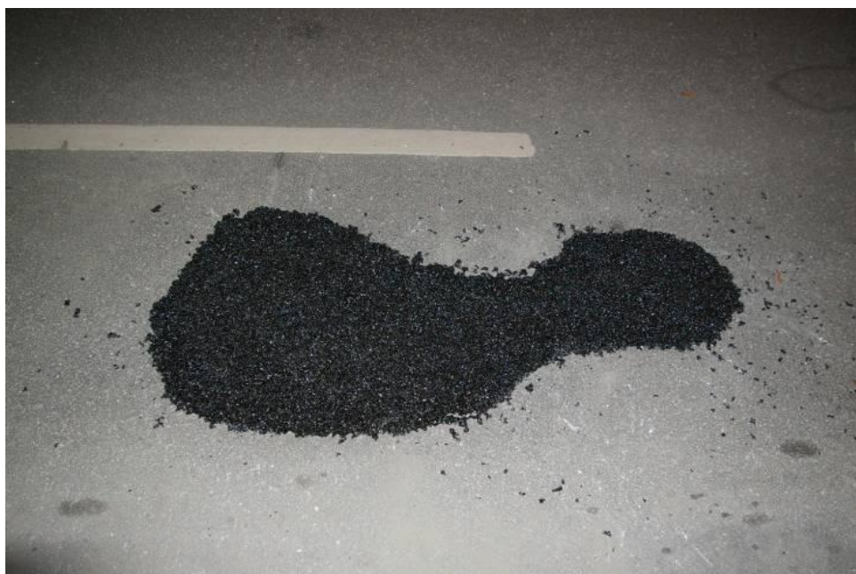
3 pav. Perma-Patch mišinio išlyginimas duobėje
