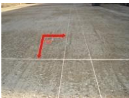
5 pav. Svarbu ištiesti virves, išlaikant tarp jų 90 laipsnių kampą .
