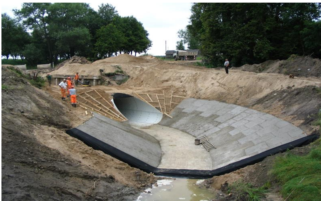
4 pav. Šlaitų tvirtinimas
